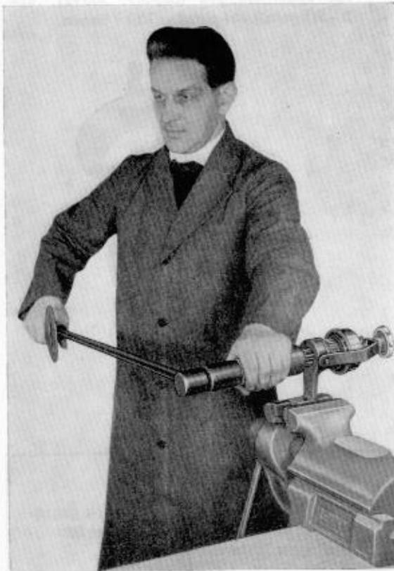
7 - Ausgleichscheiben für Axialspiel des Zahnrades für den 1. Gang einbauen. Vorgeschriebenes Spiel (0,10—0,25 mm) nach Montage des Synchronkörpers für 1. und 2. Gang zwischen der Anlaufscheibe und dem Zahnrad für 1. Gang prüfen und nötigenfalls korrigieren.
